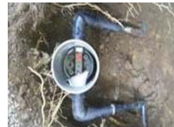
マナウォーター 内部には、かなりの圧力がかかります。土に埋める場合は、さらに土圧がかかりますので 塩ビ管等に入れて設置してください。
